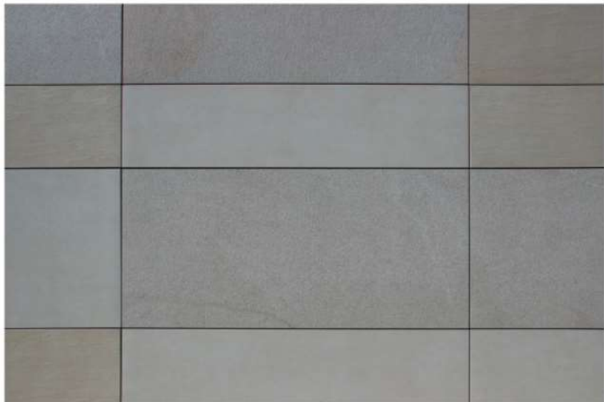
2. Dettaglio del rivestimento esterno di una facciata ventilata in grés Detail of the external coating layer of a stoneware ventilated façade
